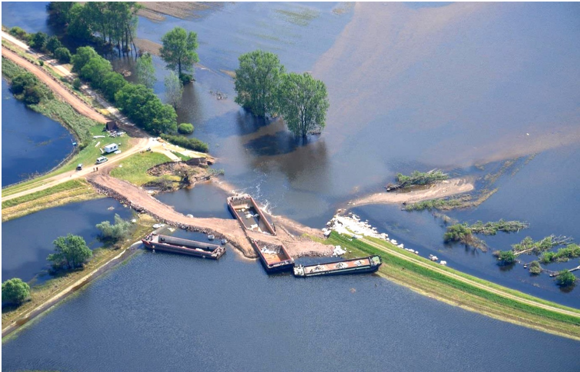
Abbildung 11: Verschlussene Deichbruchsstelle Fischbeck am 22.06.13 (Foto: Prof. Jüpner)
