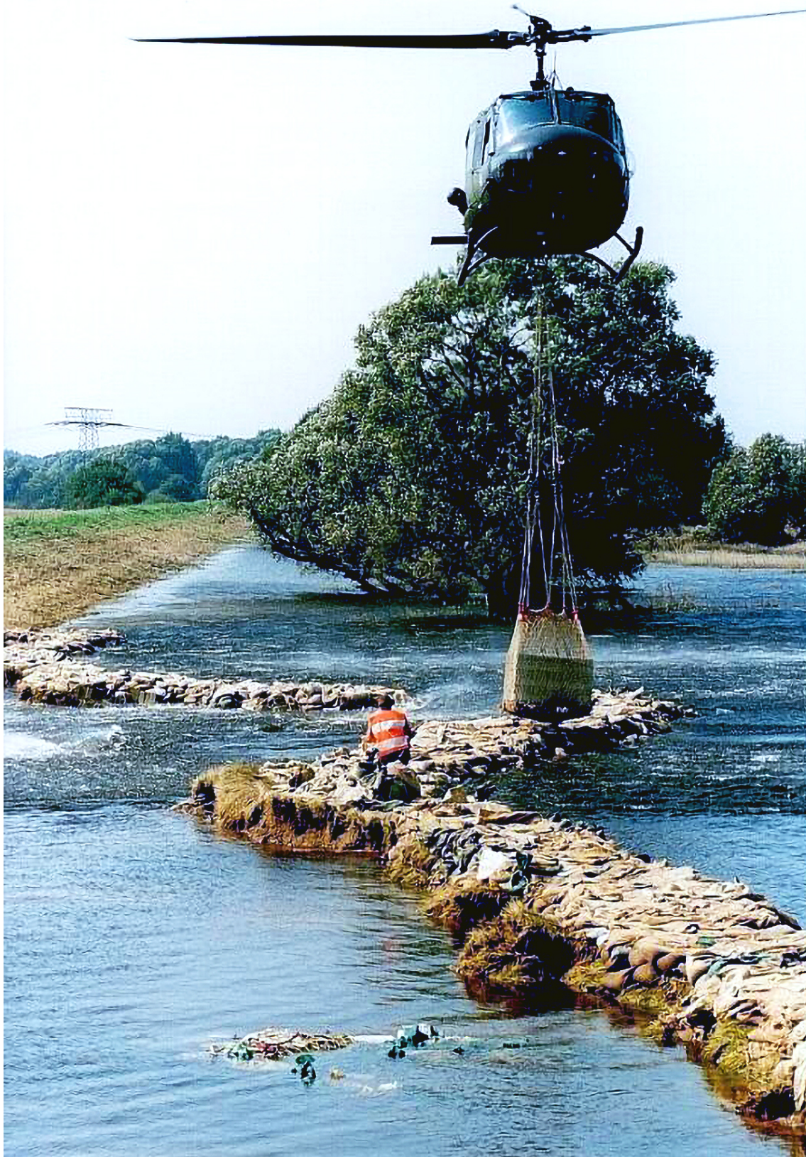
Abbildung 10: Schließung Deichbruchstelle Seegrehna, LK Wittenberg (Foto: LHW)
