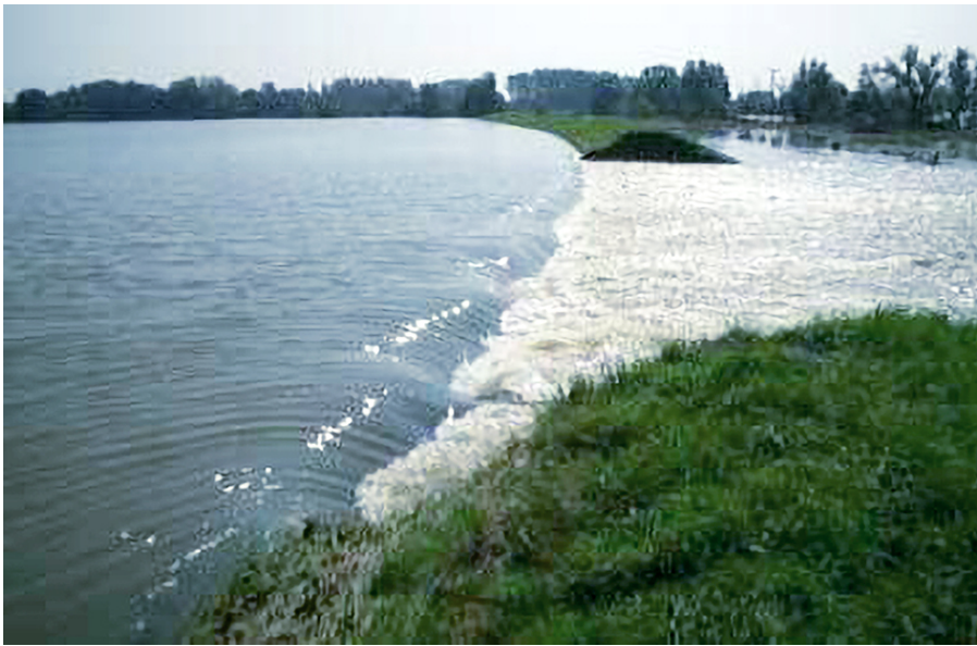
Abbildung 8: Bruch des Leinedeiches, LK Bitterfeld (Foto: LHW)
