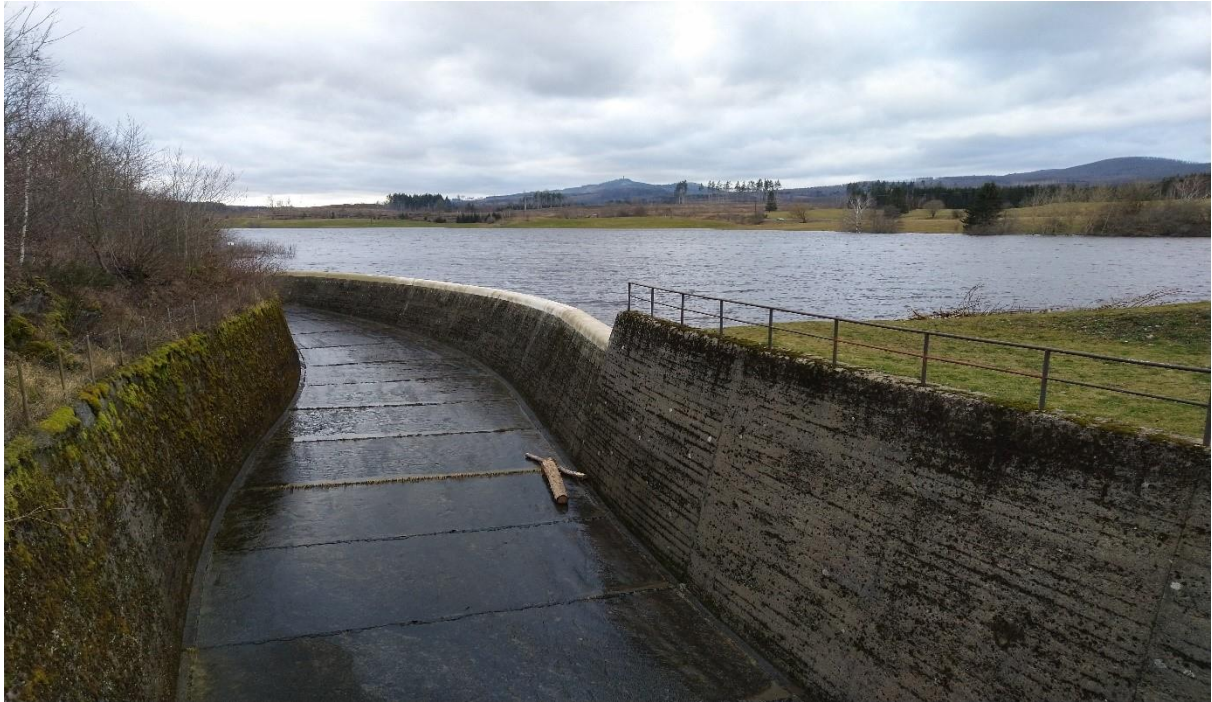
Abbildung 18 HWSB Kalte Bode: Blick über die Hochwasserentlastungsanlage zum Stauraum am 28.12.2023, Beckenpegel: 466,30 müNN (-0,20 m unter Vollstau, Inhalt: 4,35 Mio. m 3 )
